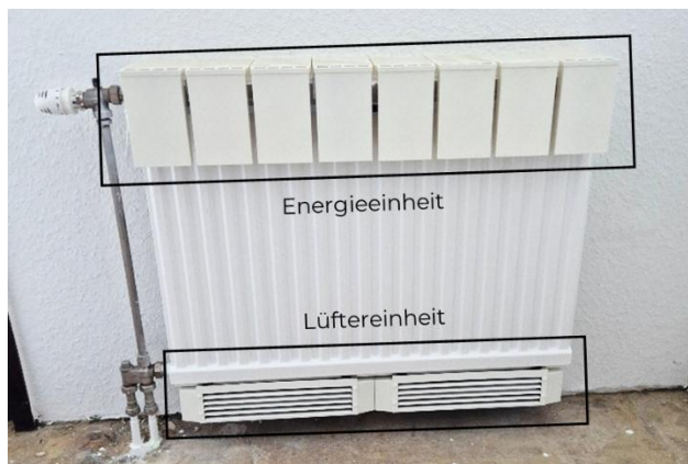
Abbildung 1: Einbaubeispiel des Optimizers im Projekt [1]
