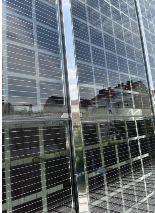
Abbildung 2: Nahaufnahme PV-Module (außen) - © Liska Raphael (Wiener Linien)
