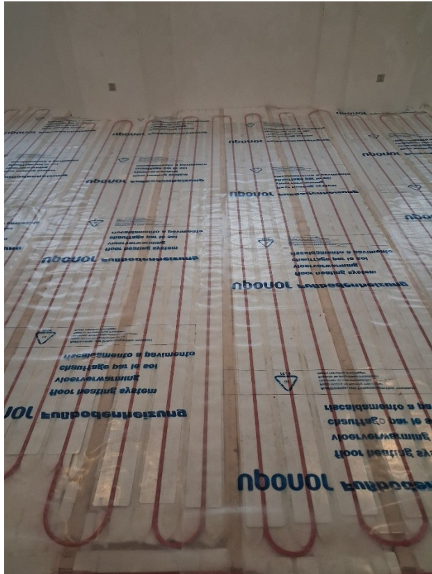
Fußbodenheizung
