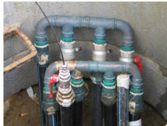
Sondenkopf mit eingebautem faseroptischen Kabel
