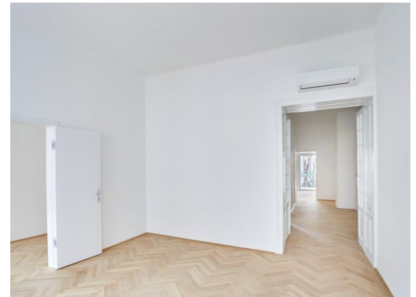
Bestandswohnung mit Fancoils in allen Aufenthaltsräumen
